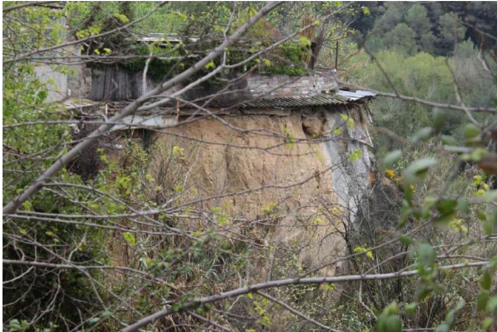
Fotografia 13: Escarpament amb petites i freqüents esllavissades al front al torrent del Salt de Can Llopart, entre els carrers de Tarragona i de Lleida (plànol 5).
