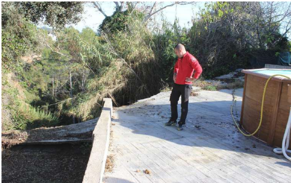
Fotografia 15: Part de la plataforma del patí de l'habitatge de la parcel·la 85 de l'av. Gran Via Diagonal afectada per la deformació dels desprendiments.
