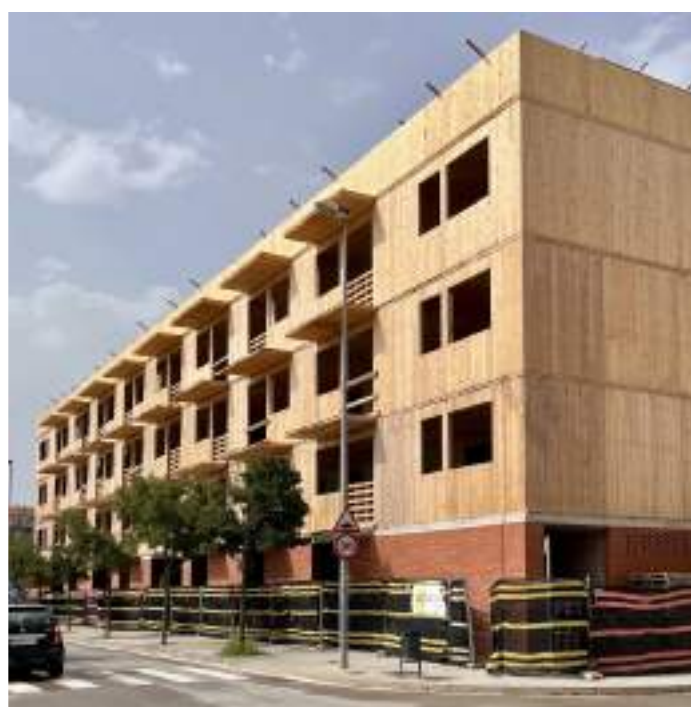
3. El cairó, obres. Font: Grupnou
