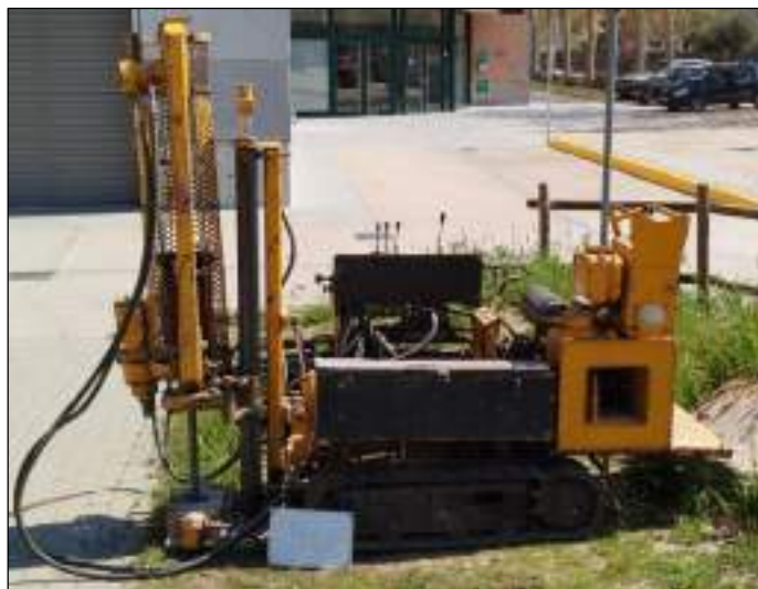
Figura 7 Maquinària de perforació i característiques tècniques
