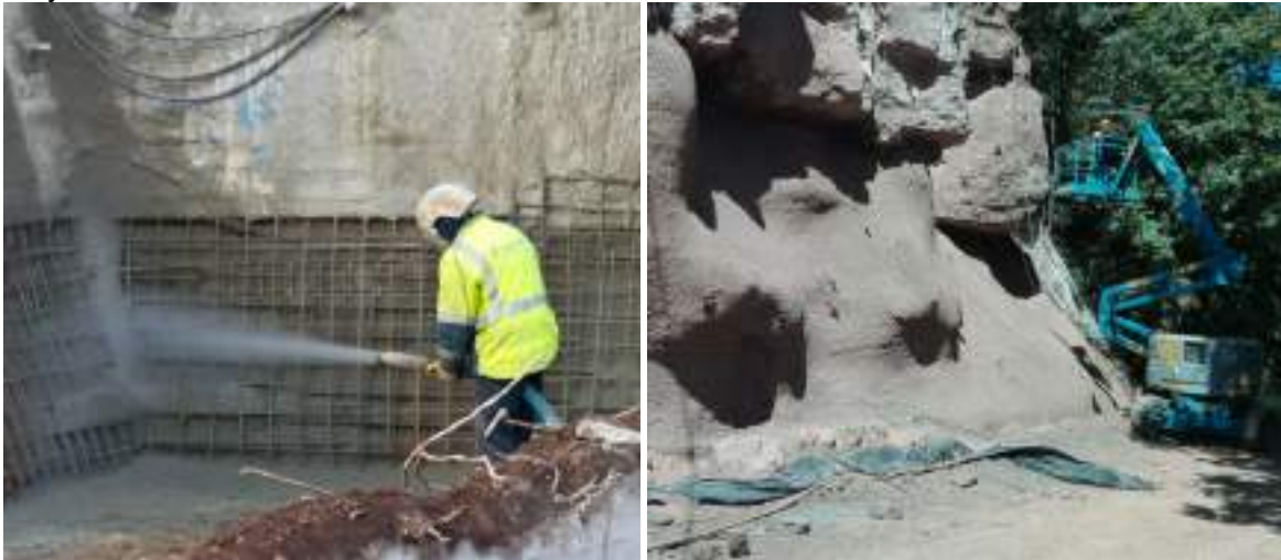
Figura 6. Exemple de gunitat obre una malla de reforç i resultat d'un gunitat sota un ressalt rocós.
