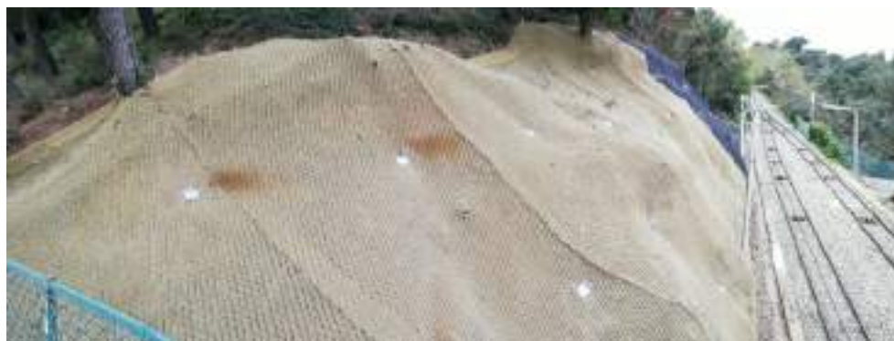
Figura 5. Talús reforçat amb geomalla per a la protecció d'una línia ferroviària. Font: GeoNeu Risk.
