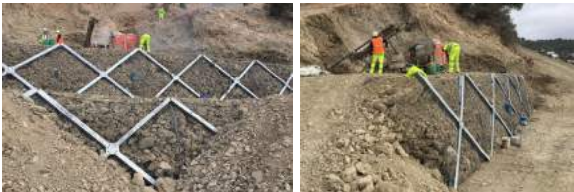
Figura 9. Estabilització d'un vessant amb esclavissades (Font: Inaccés SL).
