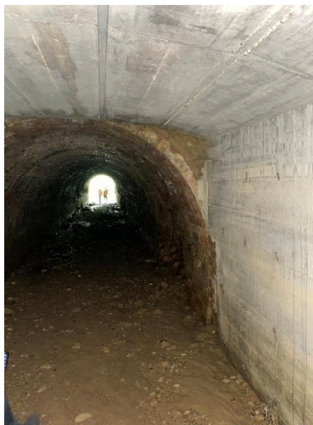
Imagen 4. Vista de la obra de la galería inferior de fábrica en el entronque con la ampliación de hormigón.
