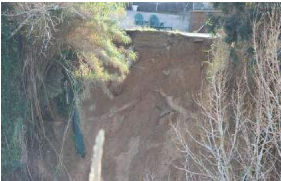
Fotografia 14: Part alta de l'escarpament on es van produir els desprendiments de finals de 2018 junt a la parcel·la 85 de l'avinguda Gran Via Diagonal, al torrent de la Font del Maset. Font: AP-0110/18 (ICGC, 2018b).
