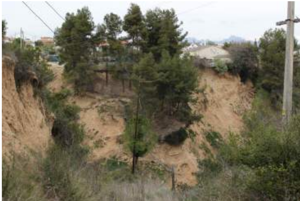
Fotografia 9. Escarpament amb petites esllavissades al front al torrent del Salt de Can Llopart, entre els carrers del Principat d'Andorra i de Barcelona (plànol 5).
