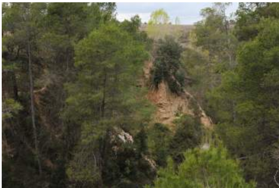
Fotografia 11. Escarpament amb indicis d'esllavissades al torrent del Salt de Can Llopart .
