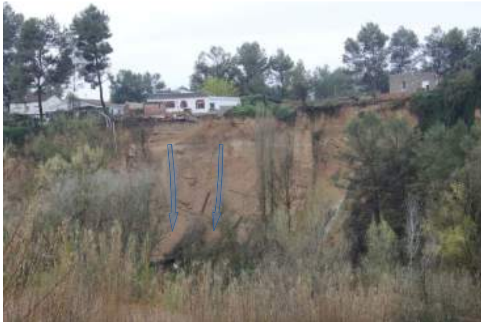
Fotografia 7. Escarpament en roca tova al torrent de la Font Santa, subàrea L (plànol 4). L'any 2013 va patir dos desprendiments que amenaçaren un dels habitatges.
