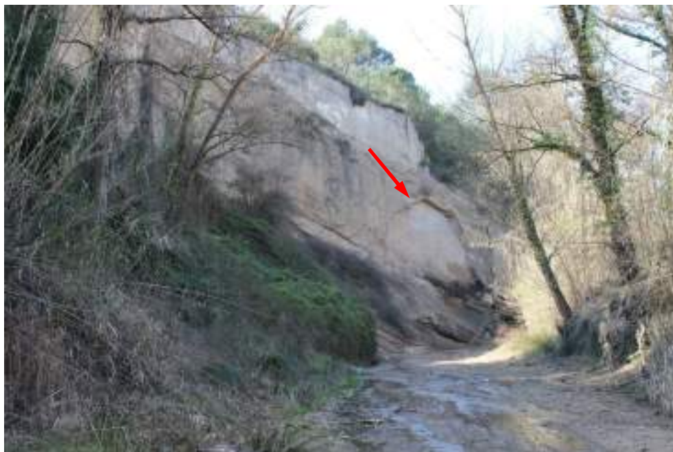
Fotografia 1. Escarpament en roca dura a la subàrea A, amb cicatrius de desprendiments recents a la riera de Masquefa.
