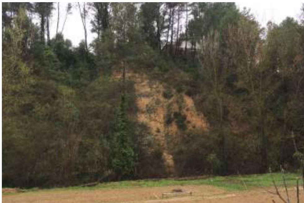
Fotografia 8. Esllavissada recent al torrent de la Font Santa, subàrea L (plànol 4).
