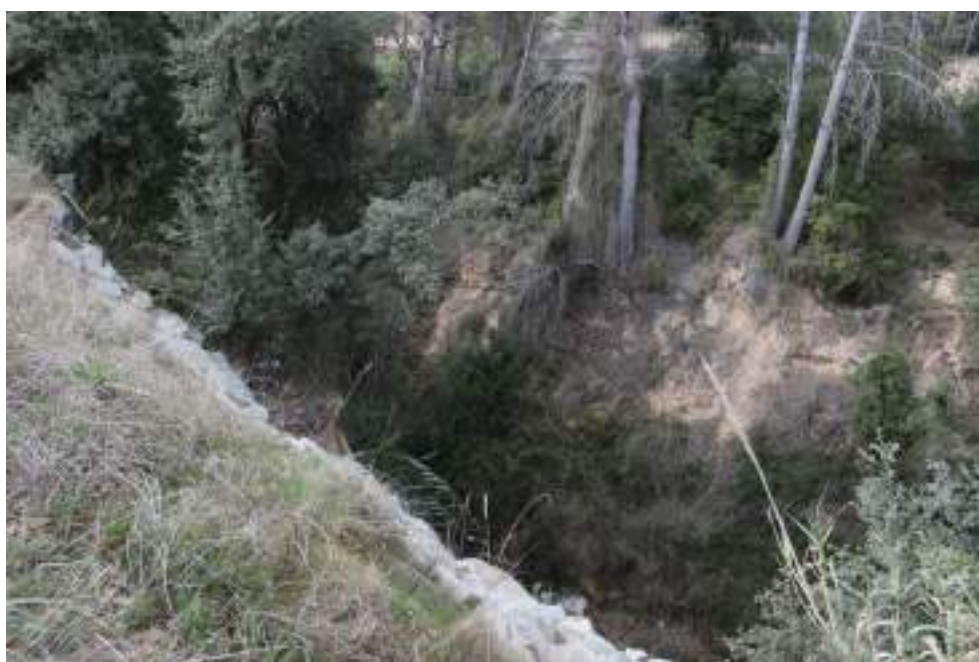
Fotografia 12. Torrent de Ca l'Esteve. En primer pla s'observa l'escullera per sostenir el camí del mas Bernic.
