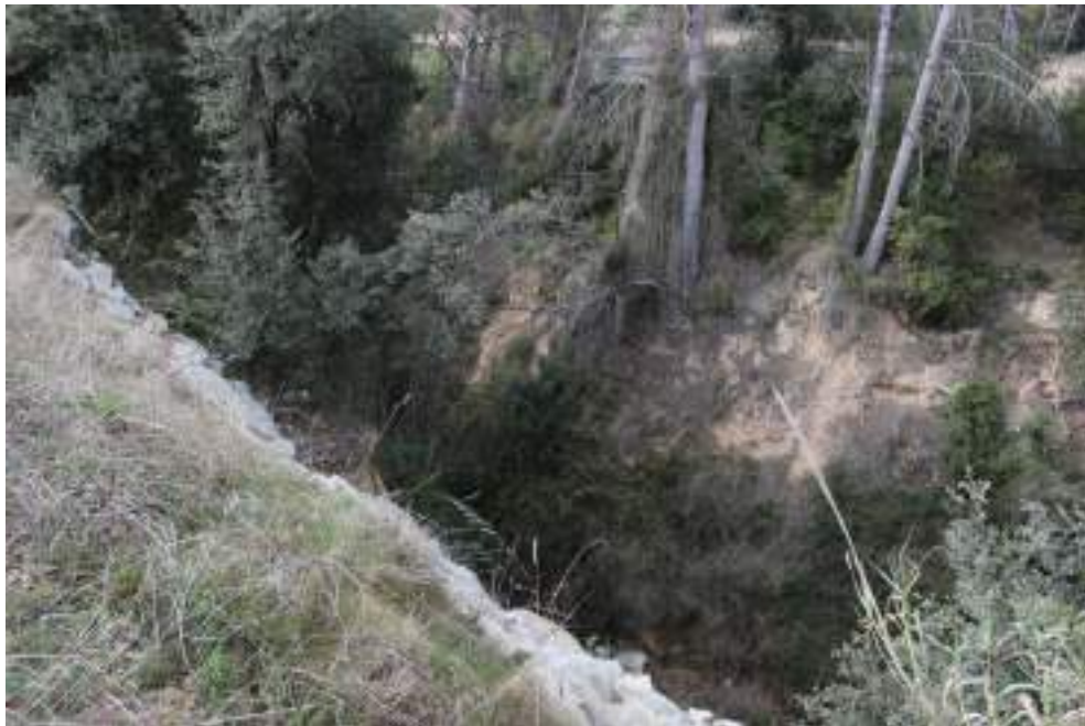
Fotografia 17: Torrent de Ca l'Esteve. En primer pla s'observa l'escullera per sostenir el camí del mas Bernic.
